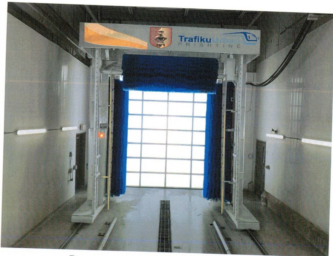
Figurë 6. - Sistem i larjes automatike të autobusëve
